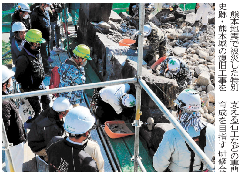
飯田丸五階櫓台の石垣を積み直す様子を見学する参加者＝熊本市中央区
