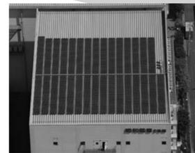
社会的責任を果たすべく環境にやさしい企業として取り組んできた返品雑誌の再資源化に加え、2010(平成22)年2月、美女木物流センター2号館の屋根に太陽光発電システムを設置。パネル528枚で100kWの太陽電池容量があり、温室効果ガスの排出量を大幅に削減。
